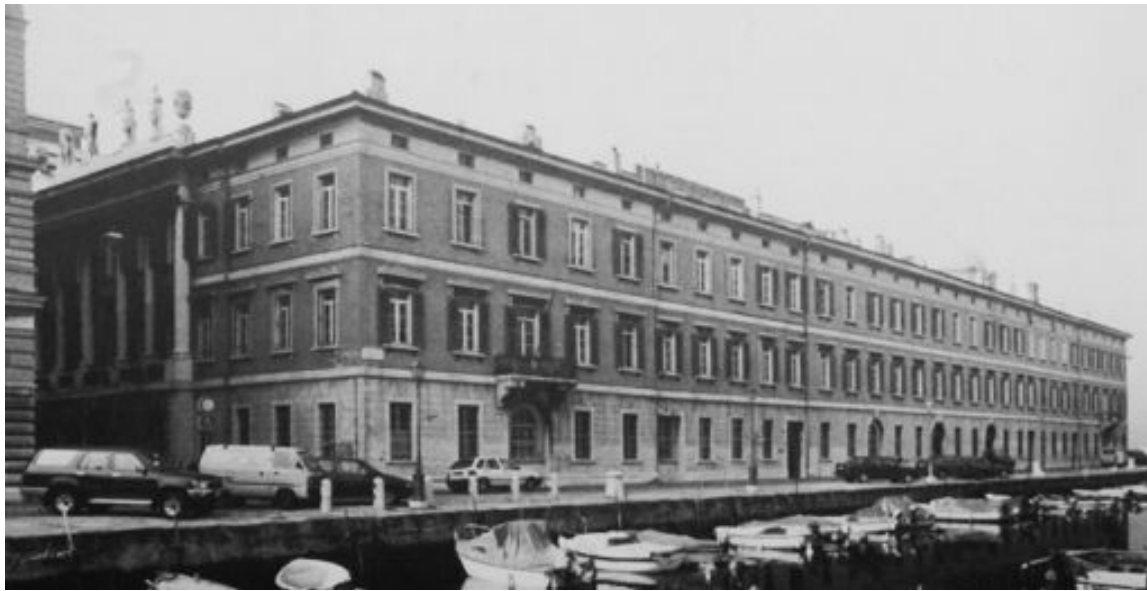
5 - MATTEO PERTSCH, Prospetto laterale di Palazzo Carciotti . Trieste, via Bellini.
